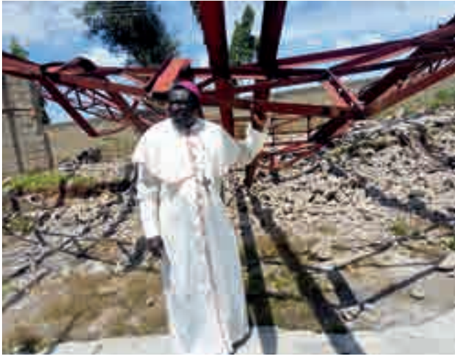
Wiederaufbau der von Boko Haram zerstörten Kirche St. Peter, Kagadama.
