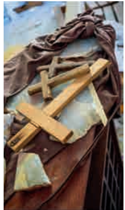
Explosionsschäden in einer Kirche in Beirut.
