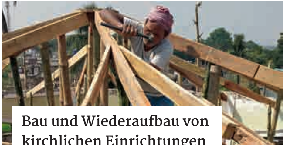
Renovierung einer Kirche in Maliapota, Indien.
