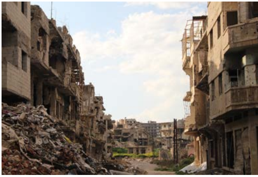
Zerstörte Strassenzüge in Homs, Syrien
